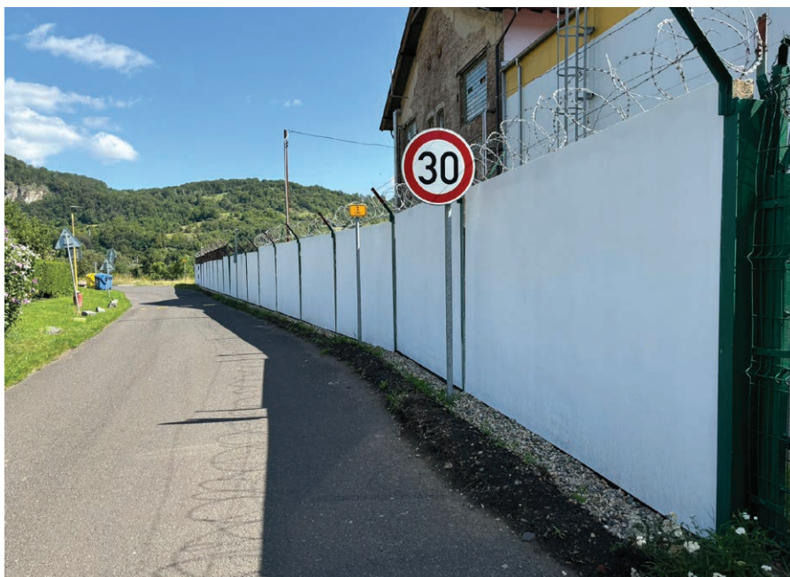
Společnost Heineken v průběhu léta opravila část nevzhledné zdi pivovaru v centru obce.
