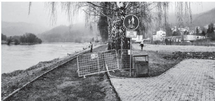
Uzavřená část cyklostezky kvůli rekonstrukci plynovodu.
