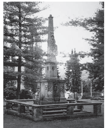
Současný stav sloupu.
