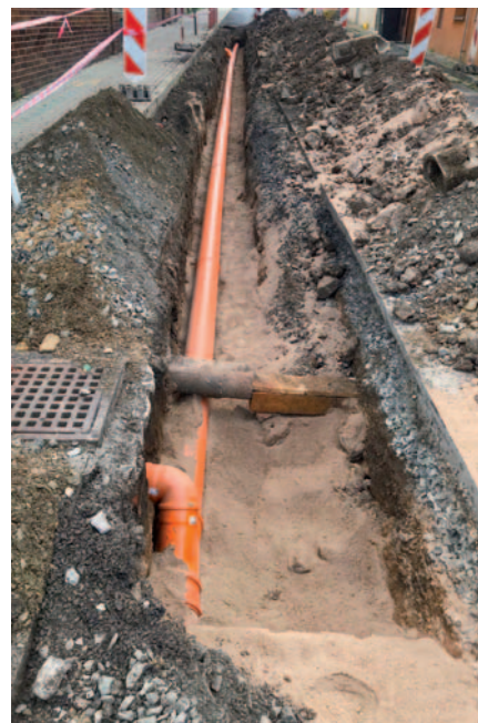
Výměna dešťové kanalizace.
