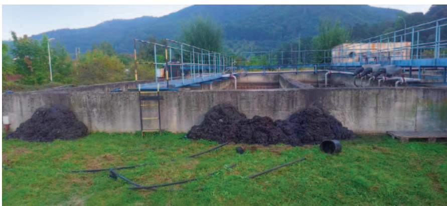
Nevhodné odpady spláchnuté do kanalizace způsobují problémy v čistírně odpadních vod.
