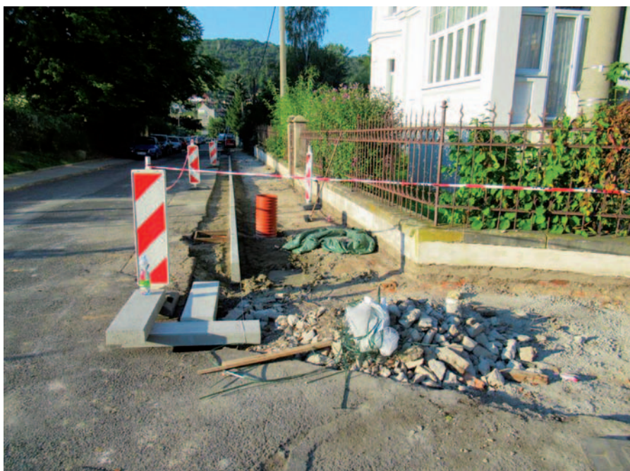
Oprava chodníku v Aleji sportovců.
