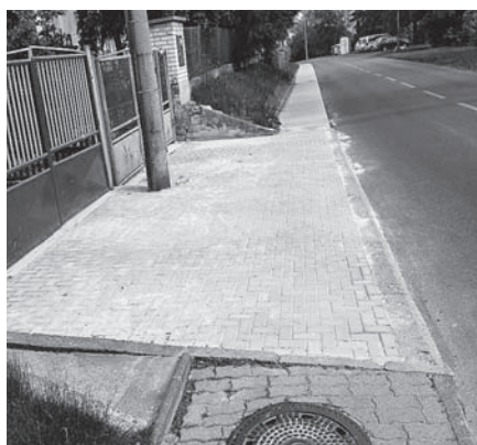
Stav před a po opravě.
