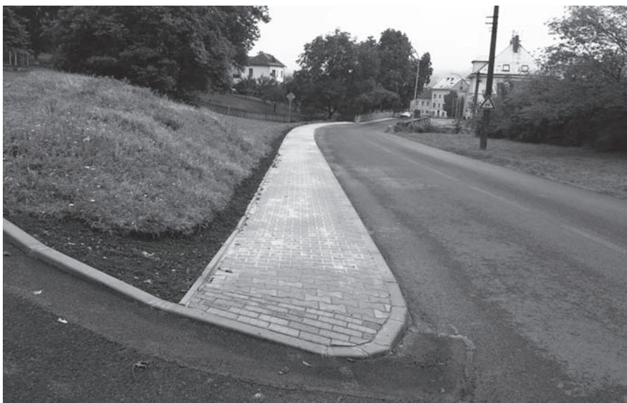
Chodník v ulici Litoměřická po rekonstrukci.
