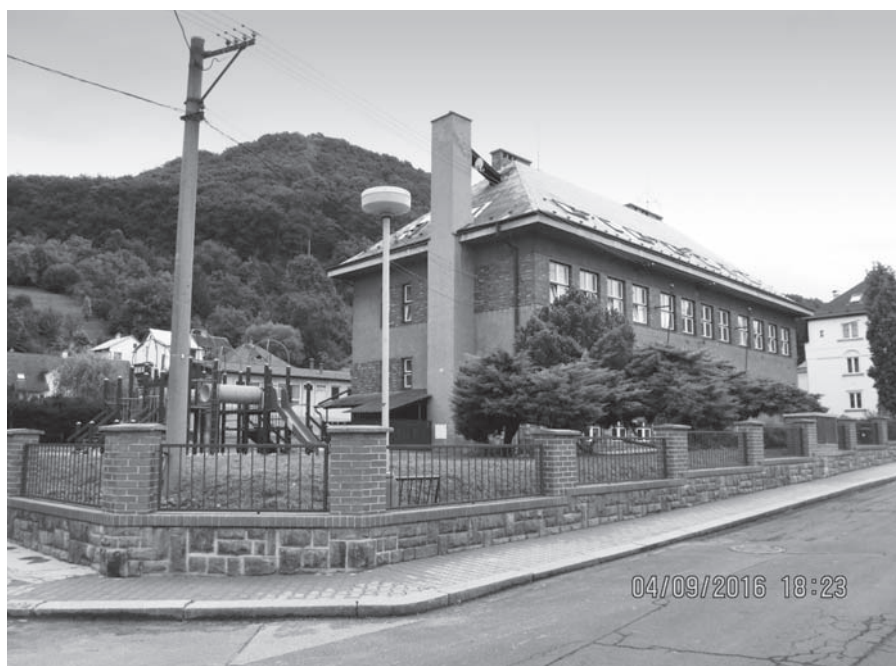
Nově opravený plot u horní budovy Základní školy Velké Březno.
