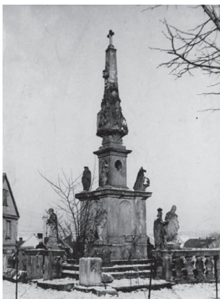
Snímek barokního sloupu z roku 1961. Foto: NPÚ, ÚOP v Ústí nad Labem.
