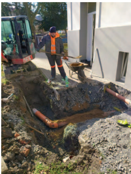
Oprava havárie na kanalizaci v Zahradní ulici.
