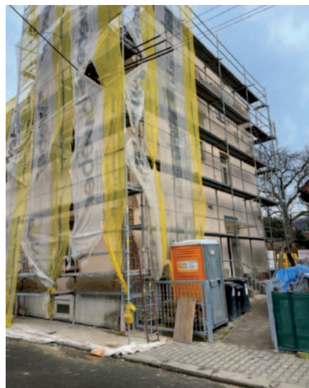
Oprava bytového domu Náměstí 171.
