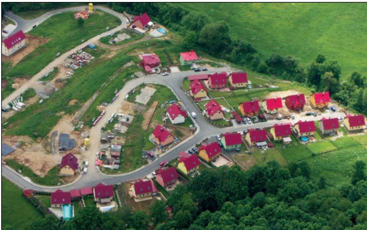
Výstavba rodinných domů - Vítov.
