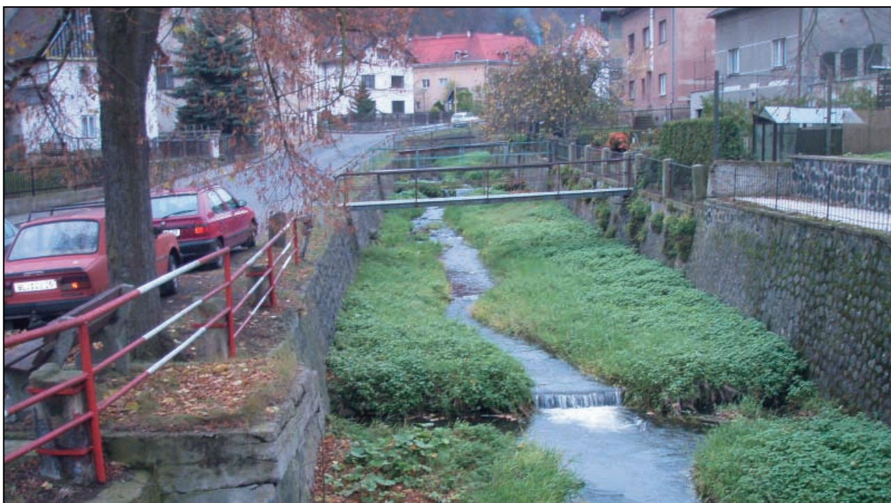
Zanešené koryto Homolského potoka.
