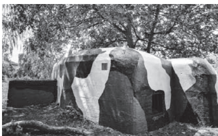
Nově opravený řopík Muzea Čs. opevnění ve Velkém Březně.
