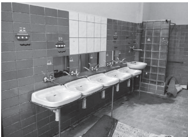
Umývárna v mateřské škole před rekonstrukcí.
