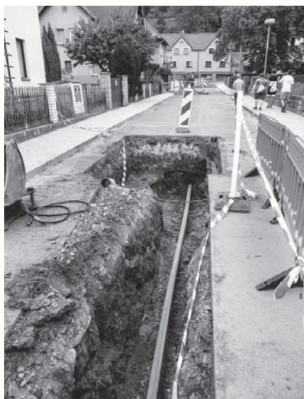
Opravy vodovodního potrubí v ulici Krátká.
